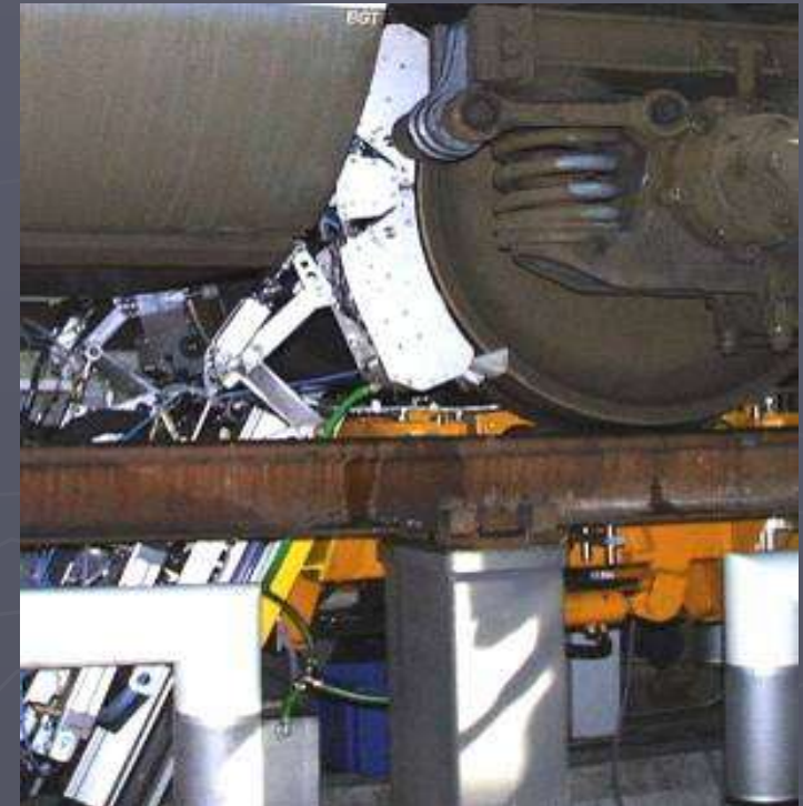
Podzemno postrojenje za ispitivanje točkova u ICE depou Centralne Minhenske stanice
